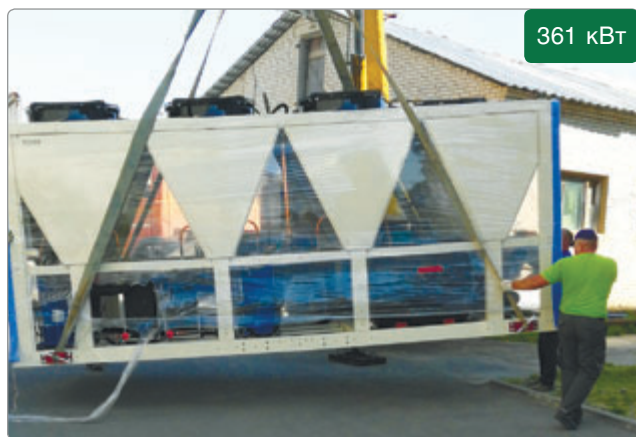
НВП «АСТРАФАРМ», БАЛАШИХА чиллер воздушного охлаждения
